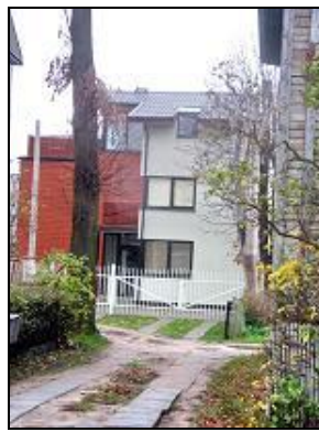
Žemuogių 6 a., 1934 m. Perstatytas į gyv. namą
