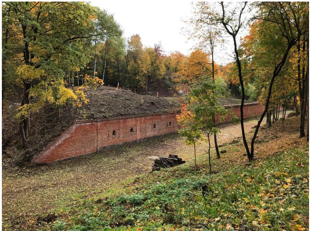
Nr. 2 Pavadinimas V forto aplinka (eskarpinė siena) Fotografavo Dovilė Miliukštė
