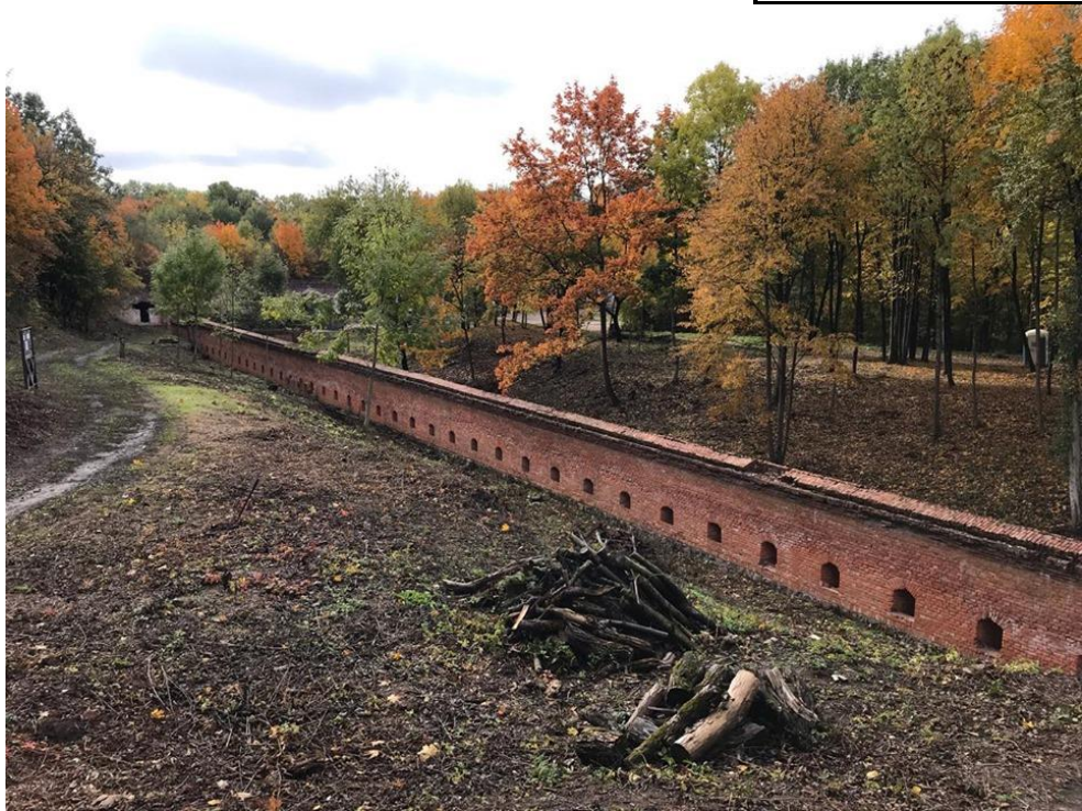
Nr. 7 Pavadinimas V forto eskarpinė siena Fotografavo Dovilė Miliukštė
