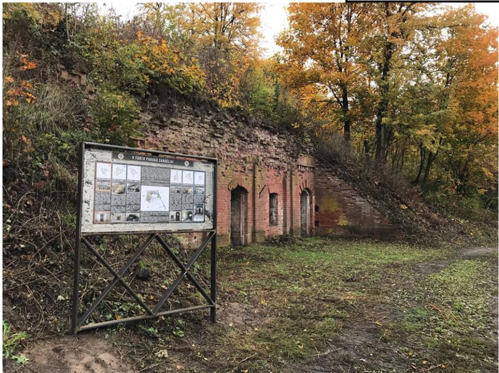
Nr. 1 Pavadinimas V forto informacinis stendas ir šiaurinis šaudmenų sandėlis Fotografavo Dovilė Miliukštė
