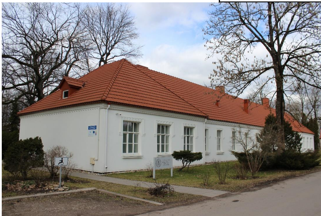
Nr. 1 Pavadinimas Aukštosios Fredos dvaro sodybos pirma oficina. PR ir PV fasadai Fotografavo Germantė Maleckaitė Data 2019-03-12
