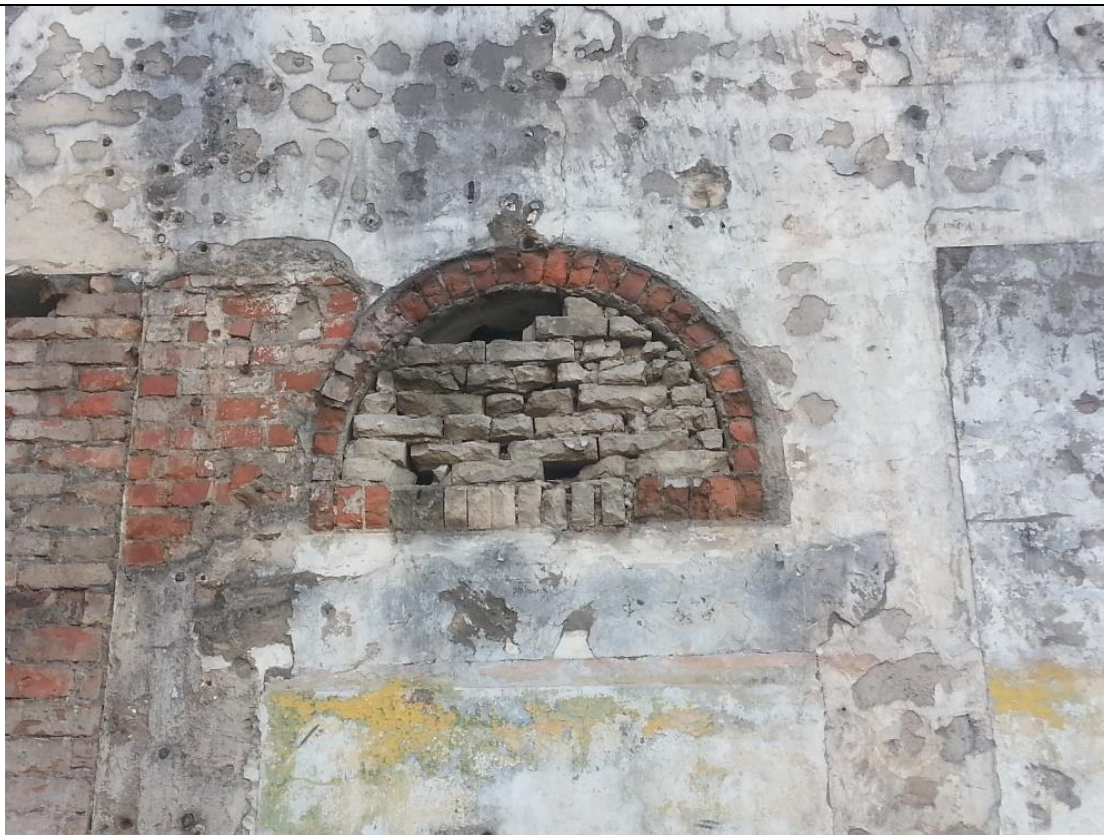
Nr. 12 Pavadinimas Sulčių fabrikas V korpusas. R fasadas. Buvusi anga Fotografavo Justas Jarumbauskas
