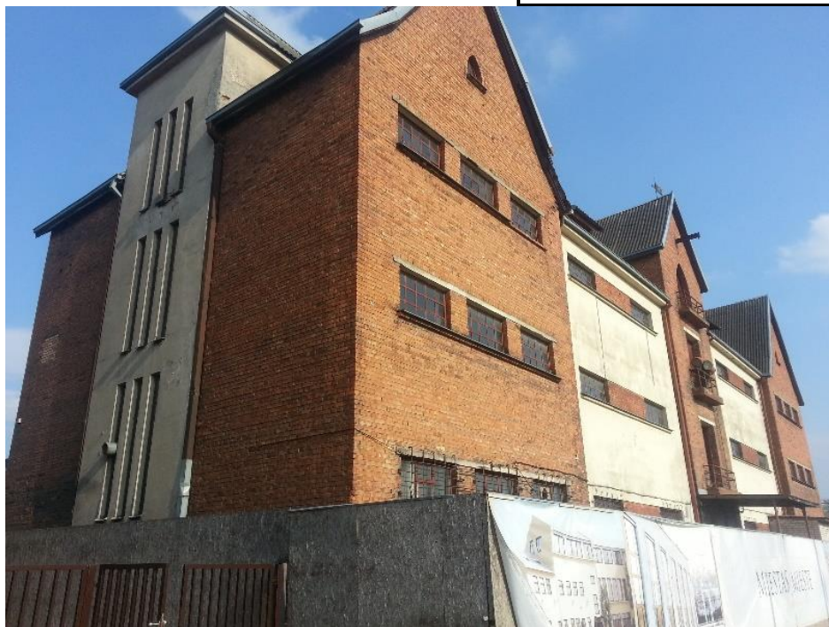
Nr. 3 Pavadinimas Sandėlio ŠV ir PV fasadai Fotografavo Justas Jarumbauskas
