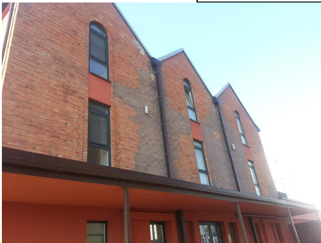
Nr. 5 Pavadinimas Pienocentro centrinės pieninės pastatų komplekso šaldytuvo pastatas PR fasadas Fotografavo Justas Jarumbauskas Data 2019-04-08
