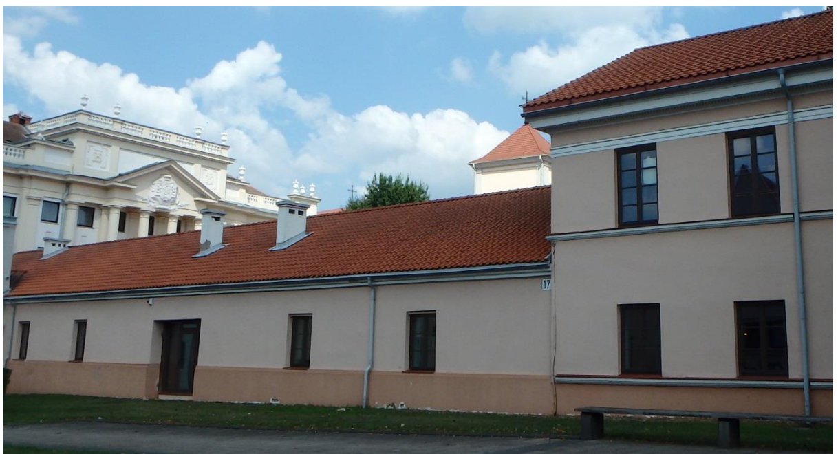
Foto Nr. 2 P fasadas
