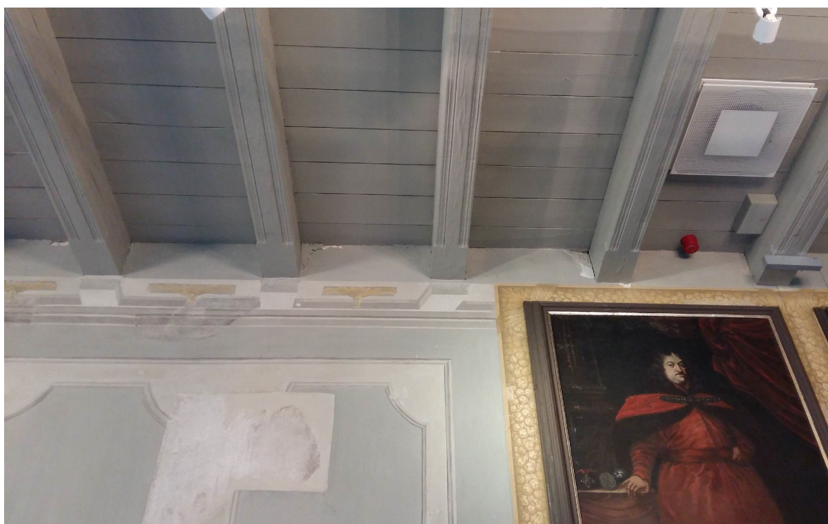
13.6. Nutrupėjęs ir įskilęs tinkas „Fundatorių“ salės palubėje (F-6).
