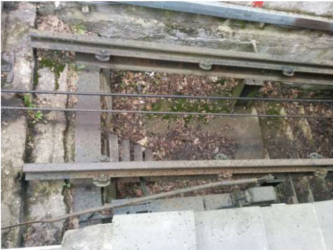
(F-3). Kelio fragmentas su viršutinėje stoties dalyje. Apsauginiai buferiai, avarinio stabdžio svirtis;
