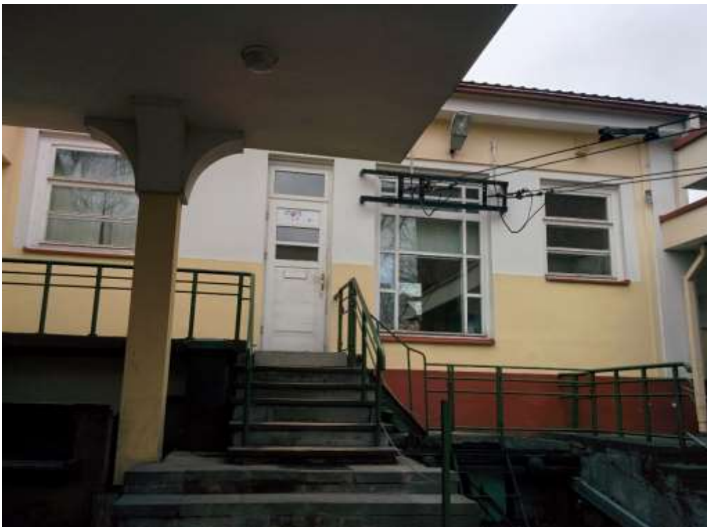
(F-4). Viršutinės stotelės funikulieriaus valdymo patalpos.
