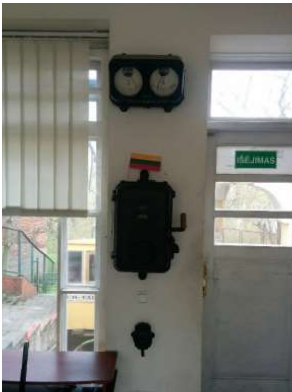
(F-6). Stotis. I a. valdymo patalpos įranga: elektros įvadinis kirtiklis, variklio išjungimo jungiklis ir voltmetras su ampermetru.
