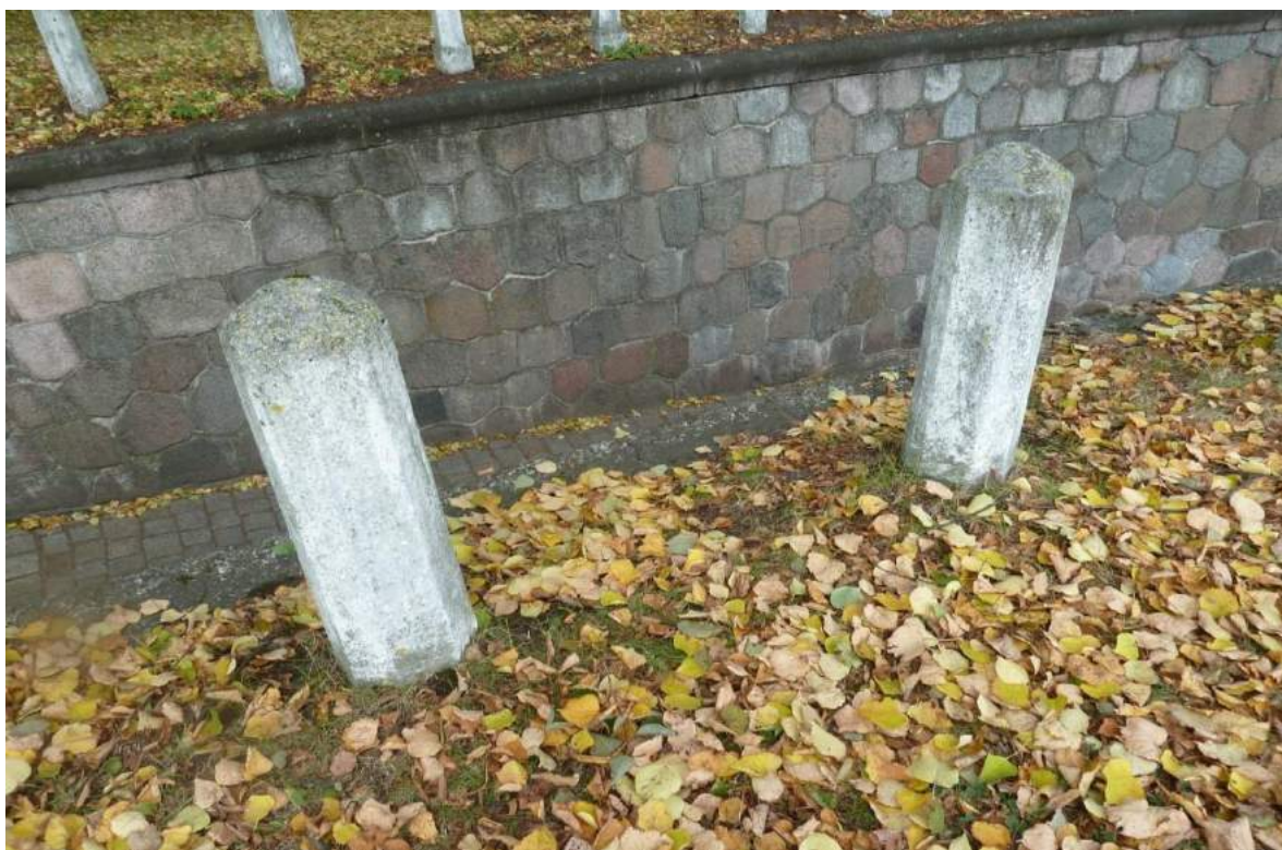
F6. Autentiški betoniniai stulpeliai (S8) Fotografavo N.Steponaitytė. 2016-10-18
