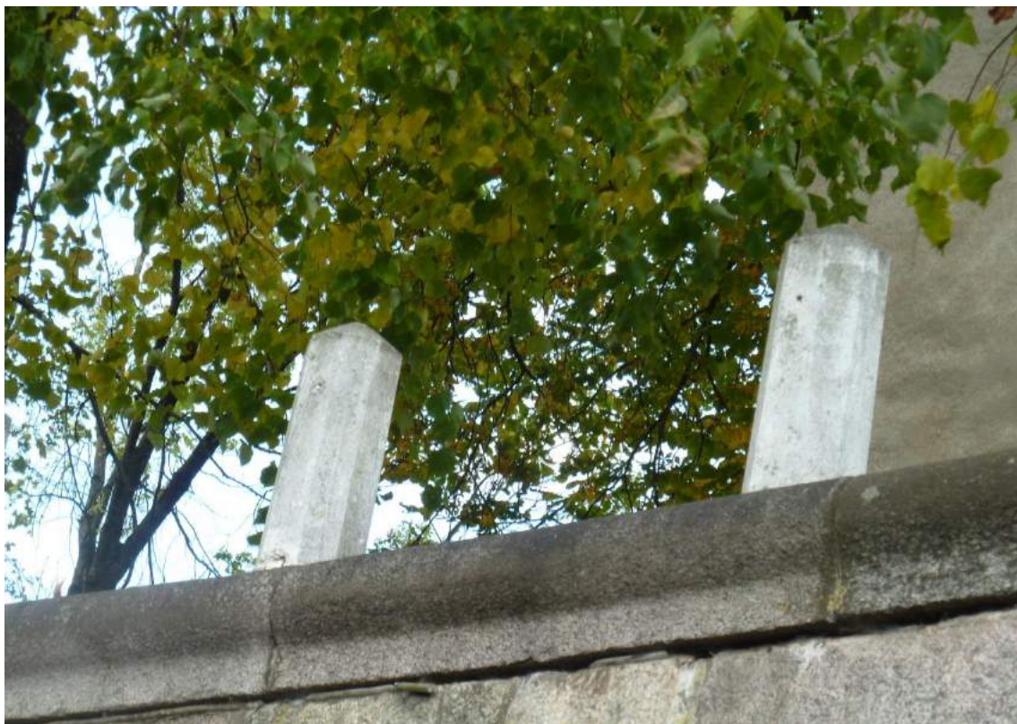
F17. Profiliuotos Prieplaukos g. šiaurinės atraminės sienos profiliuotos karnizų plokštės (S8) Fotografavo N.Steponaitytė. 2016-10-18
