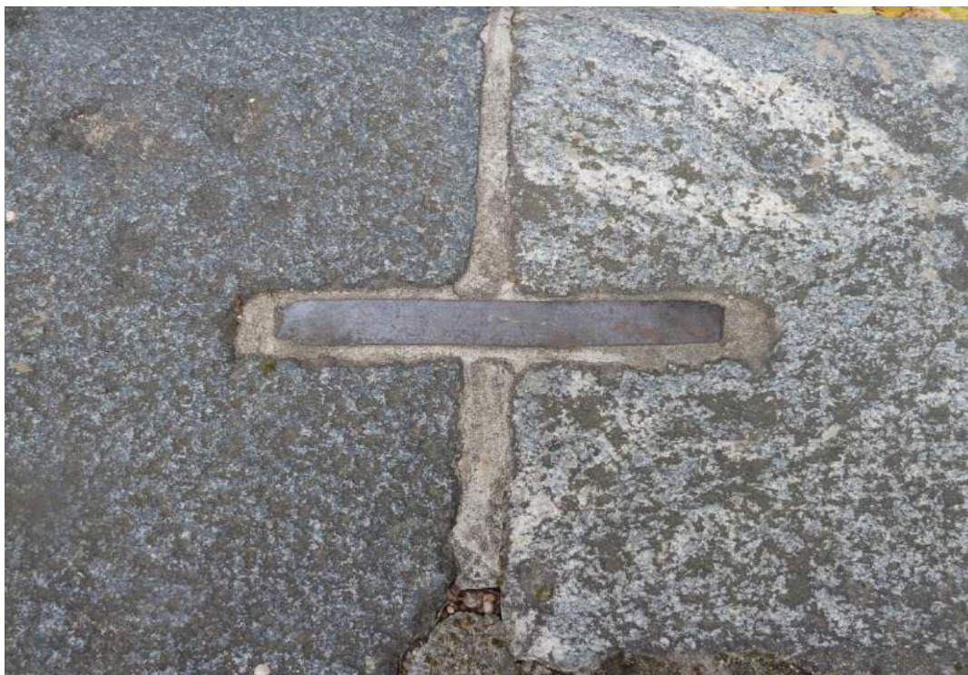
F3. Metalinės kabės granitinių karnizo plokščių tvirtinimui (S6)
