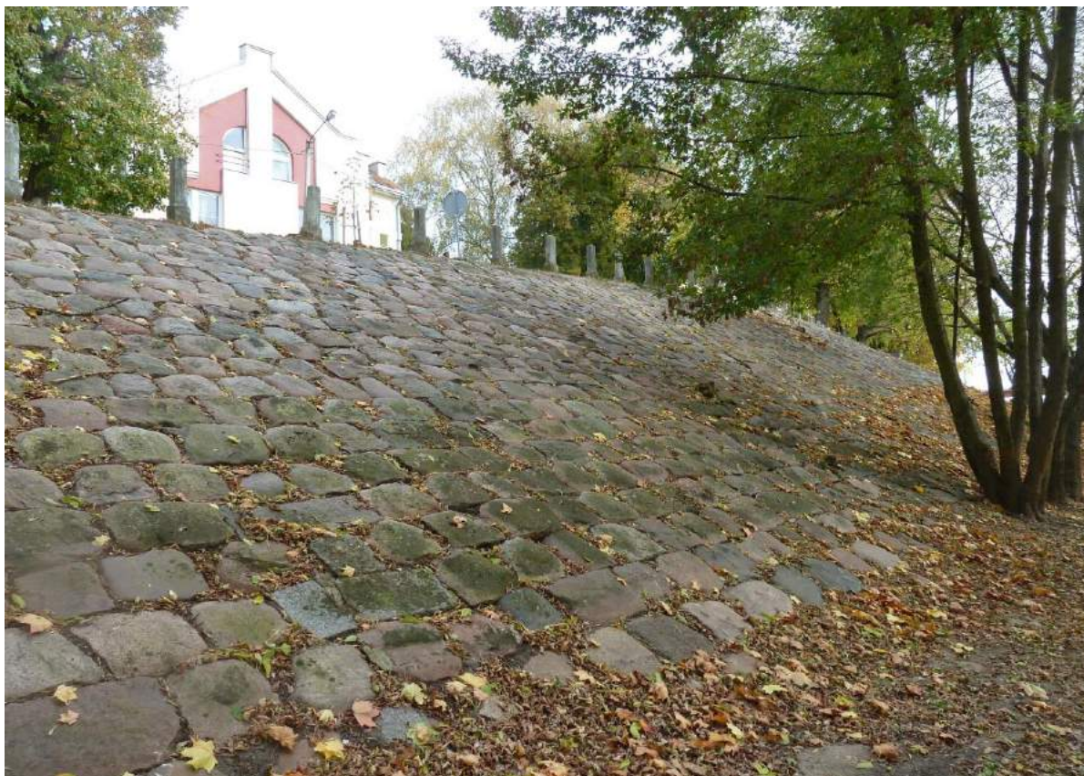
F9. Tašytų akmenų Prieplaukos g. šlaito grindinys (S1, S8, S11, S19) Fotografavo N.Steponaitytė. 2016-10-18
