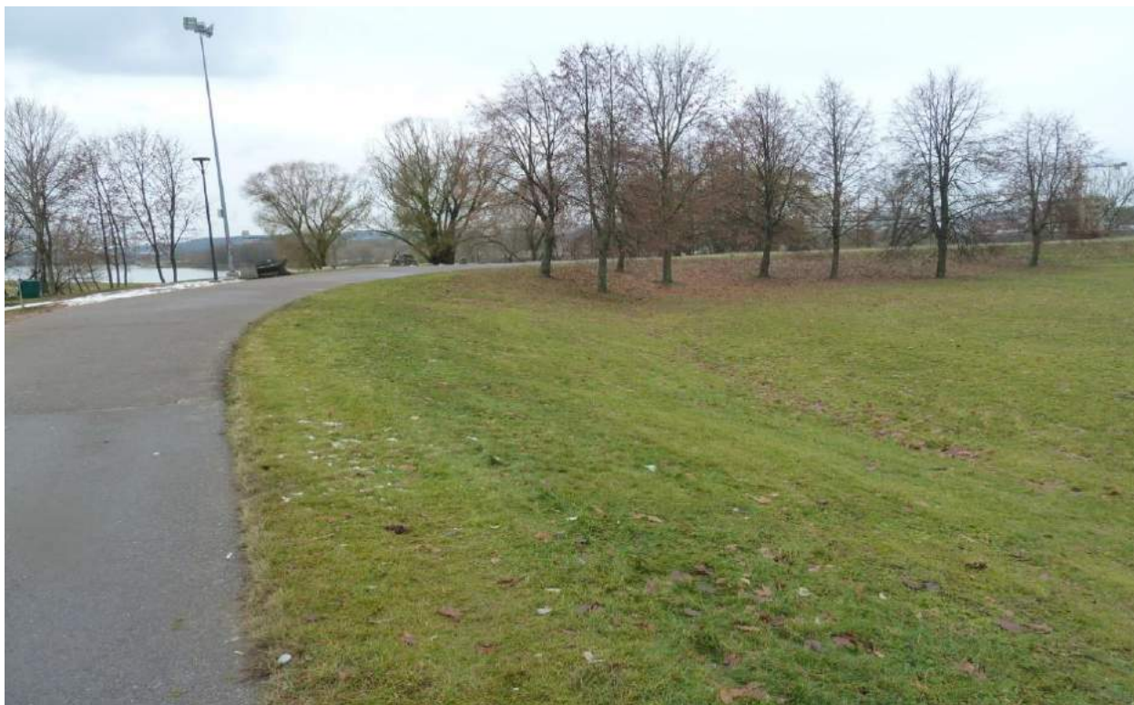
F19. Santakos pylimas (S2, S3, S15) Fotografavo N.Steponaitytė. 2016-11-20
