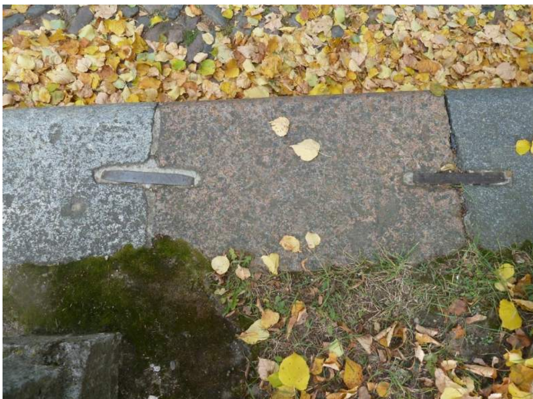
F4. Metalinės kabės granitinių karnizo plokščių tvirtinimui (S6)
