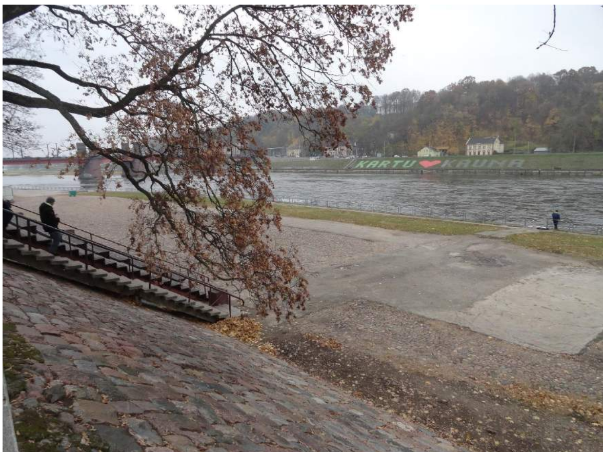
F24. XIX a. II p. istorinės priekplaukos gabaritų liekanos su riedulių danga, dangos fragmentai, išlikę grindinio fragmentai po asfalto danga (S12, S16, S17) Fotografavo J.Ragauskienė. 2016-10-28
