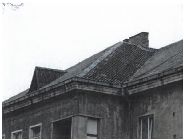
9 pav. Pastato senos asbestcementinės stogo dangos vaizdas
