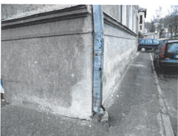
6 pav. Pastato senos lietaus nuotekų sistemos fragmentas
