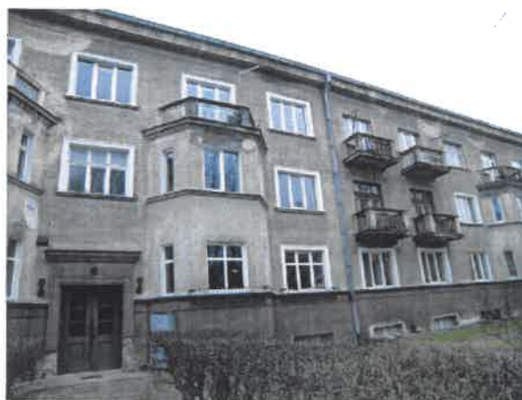
2 pav. Pastato vakarinis fasadas
