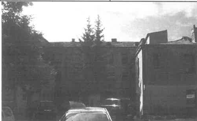
1 pav. Šiaurės fasadas
